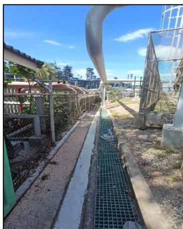
รูปที่ 2-9 รางระบายน้ำฝนโดยแยกน้ำฝนปนเปื้อนและน้ำฝนไม่ปนเปื้อนออกจากกัน
