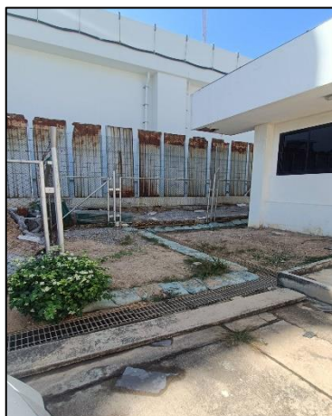
รูปที่ 2-9 รางระบายน้ำฝนโดยแยกน้ำฝนปนเปื้อนและน้ำฝนไม่ปนเปื้อนออกจากกัน
