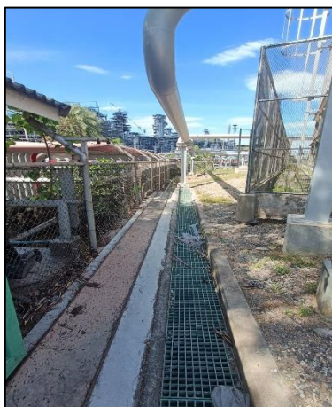
รูปที่ 2-9 รางระบายน้ำฝนโดยแยกน้ำฝนปนเปื้อนและน้ำฝนไม่ปนเปื้อนออกจากกัน
