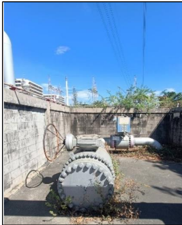
รูปที่ 2-25 ระบบควบคุมการ Shutdown ท่อส่งก๊าซธรรมชาติ
