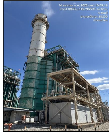
รูปที่ 2-2 ปล่องระบายอากาศเสีย สูง 53 เมตร
