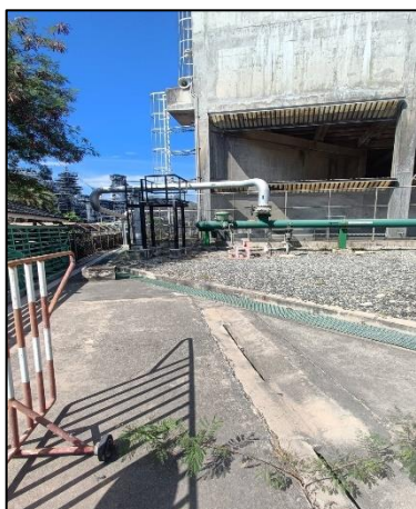
รูปที่ 2-9 รางระบายน้ำฝนโดยแยกน้ำฝนปนเปื้อนและน้ำฝนไม่ปนเปื้อนออกจากกัน
